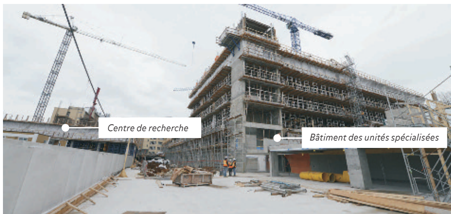
Vue à partir du 5757 Decelles de l'esplanade nord en construction - Décembre 2013
